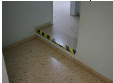
Graó aïllat a sala d'extraccions
