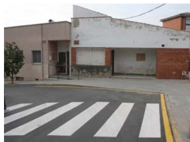
Zona de parada de vehicles
