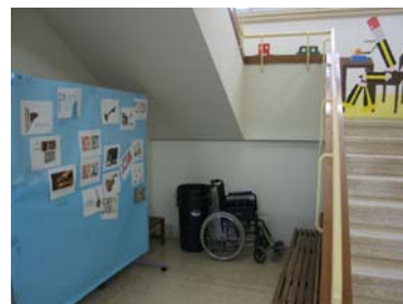
Escalera 1. Tram inferior
