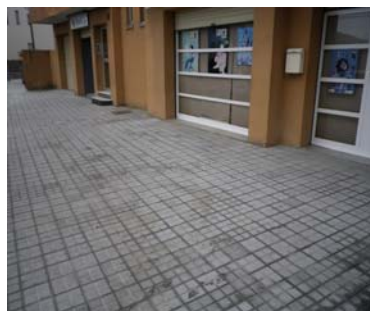
Zona exterior d'accés
