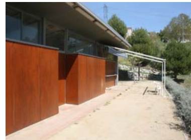
Pavelló de vestidors amb cafeteria al fons
