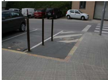
Gual peatonal junt a aparcaments
