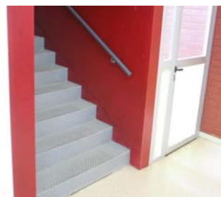
Escalera 2. Tram inferior
