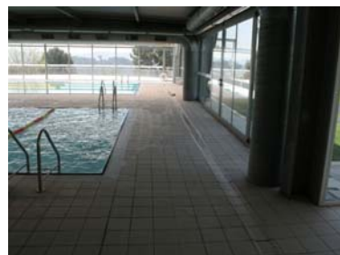
Zona de piscines
