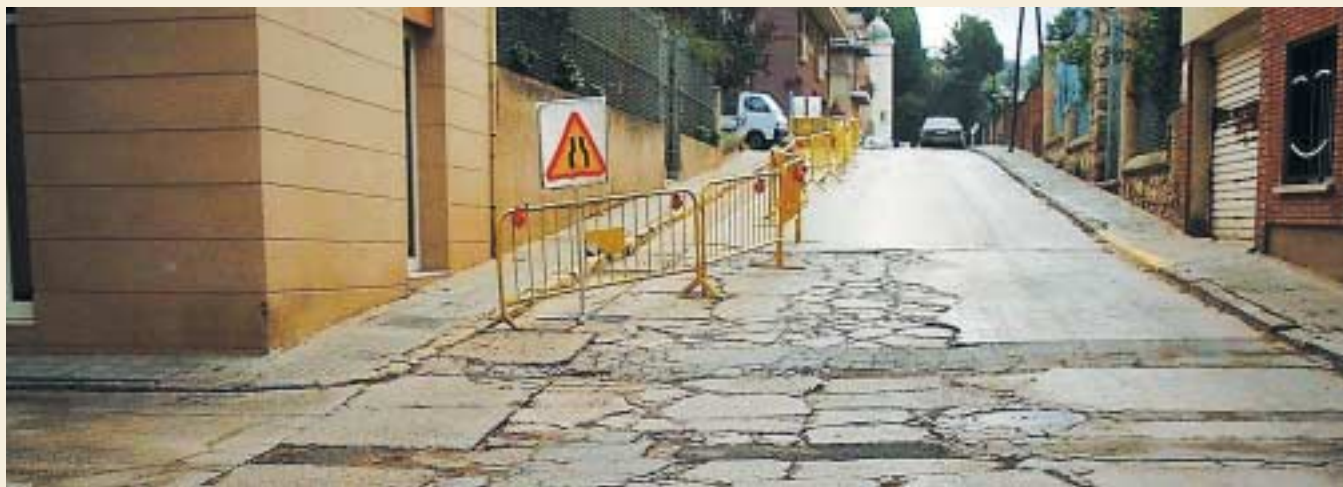
Detall de l'estat actual de l'asfaltat
