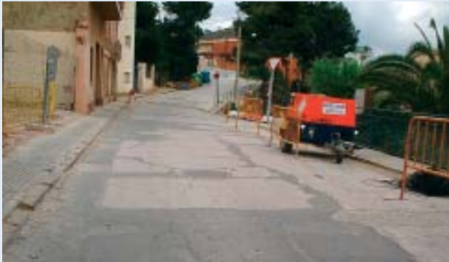
Carrer del Carme abans de les obres
