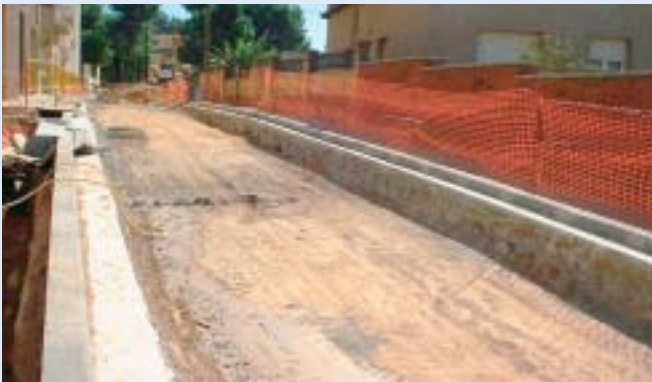
Estat actual de les obres
