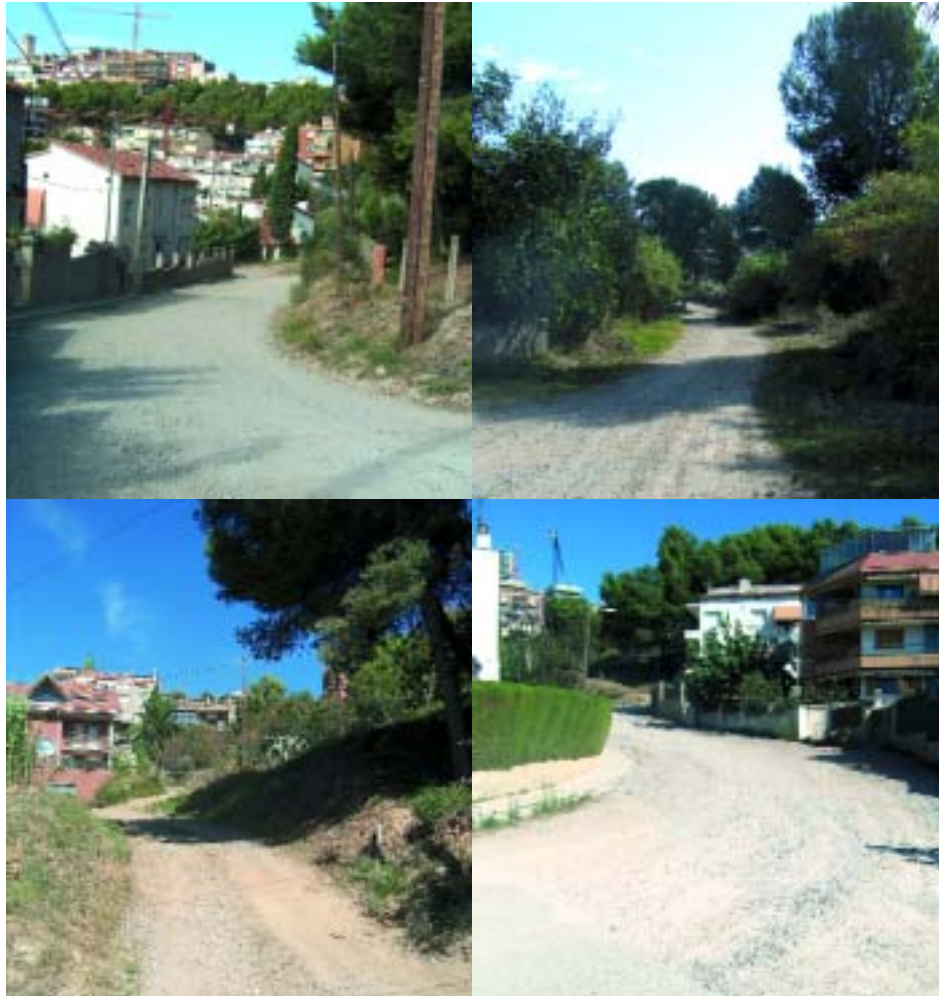
Imatges dels carrers que esperen ser reformats
