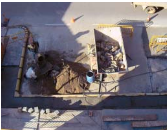
Un moment de les obres
