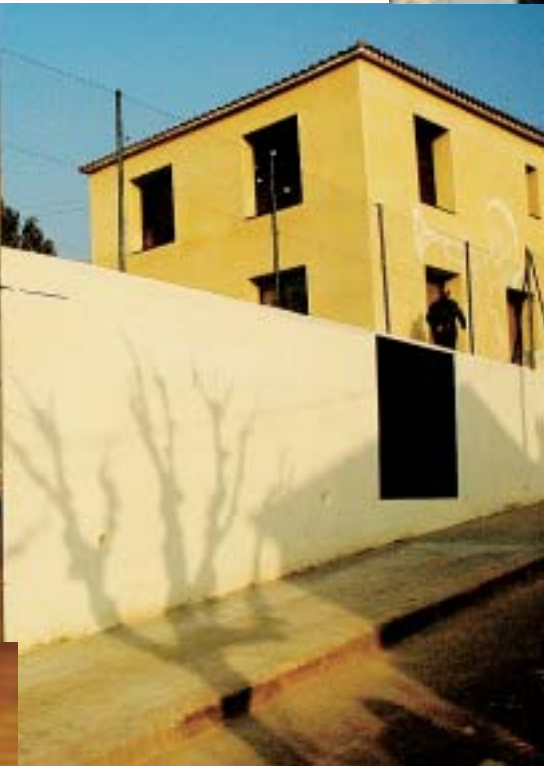
L'Escola ocupa l'espai de les antigues escoles
