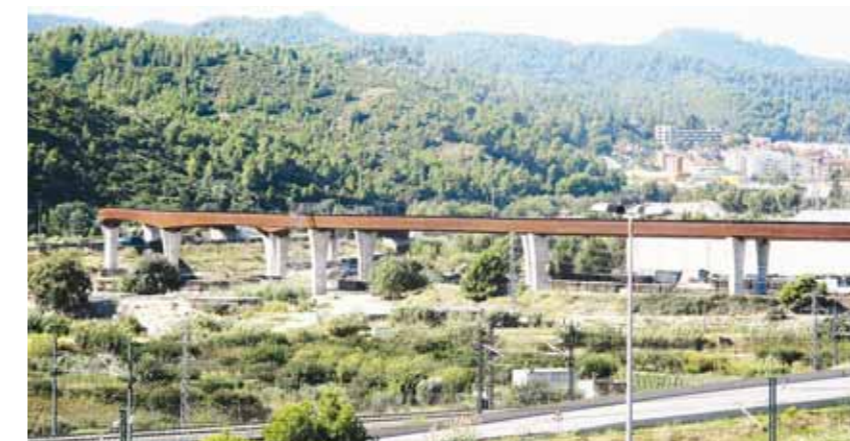
Vista de les obres al terme municipal de Castellbisbal
